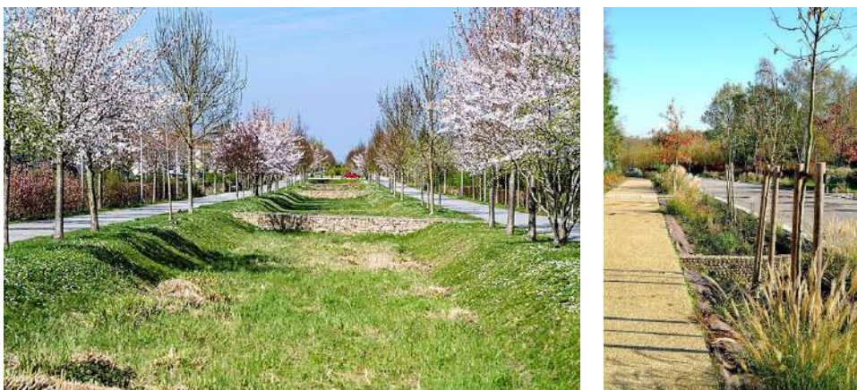
Noues plantées et bassins de rétention en accompagnement des voies de circulations, routière, cyclable et piétonne.
