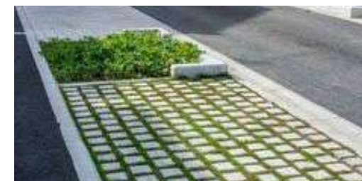
Les espaces perméables : Les procédés sont multiples et fiables pour des aires de stationnement à sol drainant
