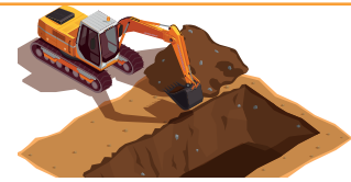
Travaux en cours d'eau
